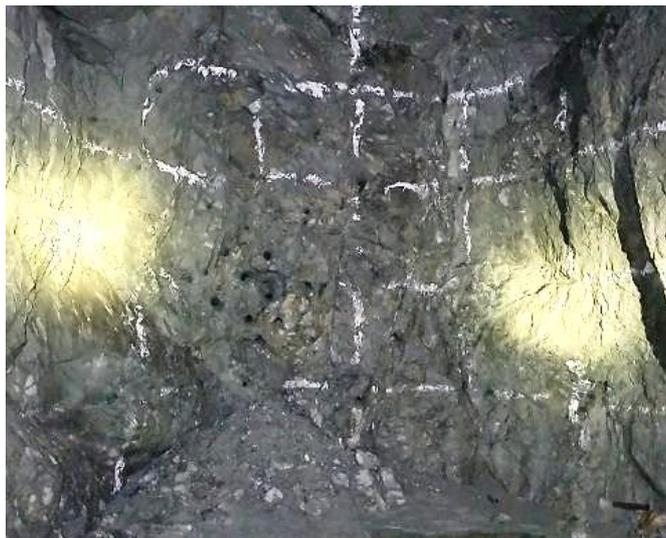
**Figura 19.** Frente perforado y marcado de colas para control de perforación
