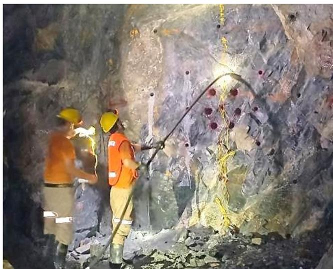
**Figura 20.** Personal realizando carguío del arranque
